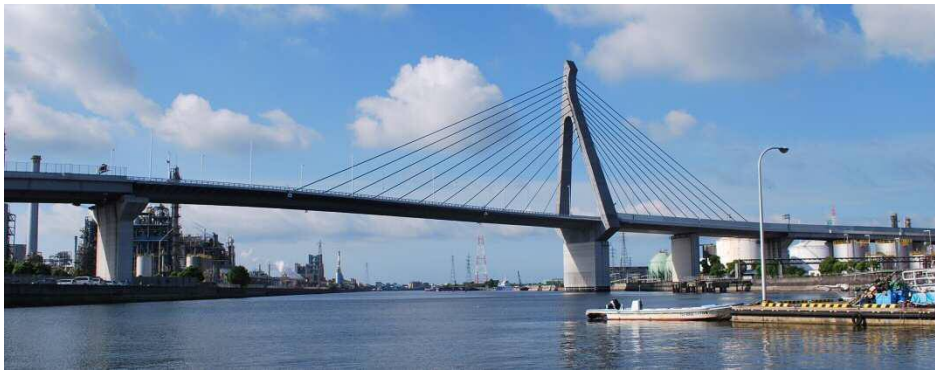
栄川運河橋(平成24年7月)
