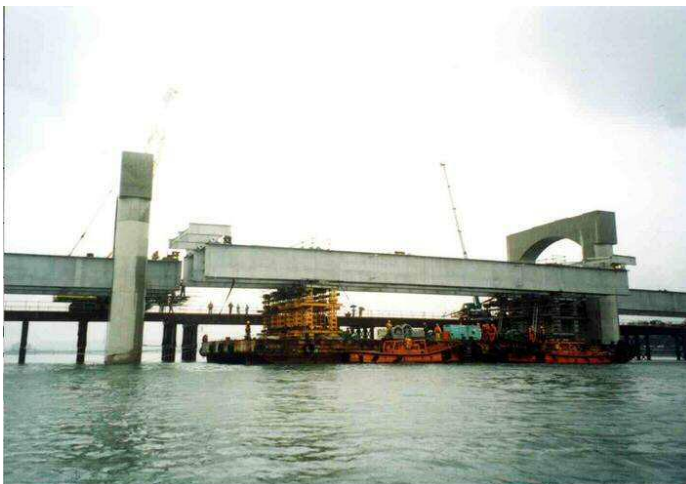
厚東川新橋施工状況(平成18年9月)
