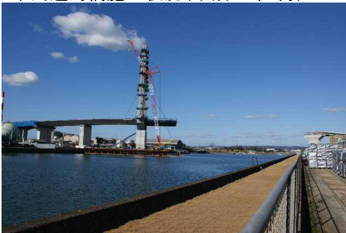
栄川運河橋施工状況(平成20年1月)
