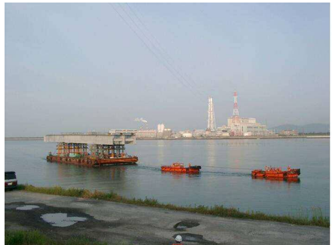
厚東川新橋施工状況(平成18年9月)
