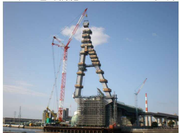
栄川運河橋施工状況(平成20年1月)
