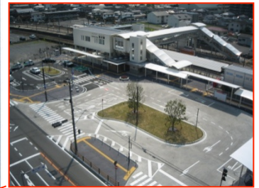
完成した東口駅前広場
