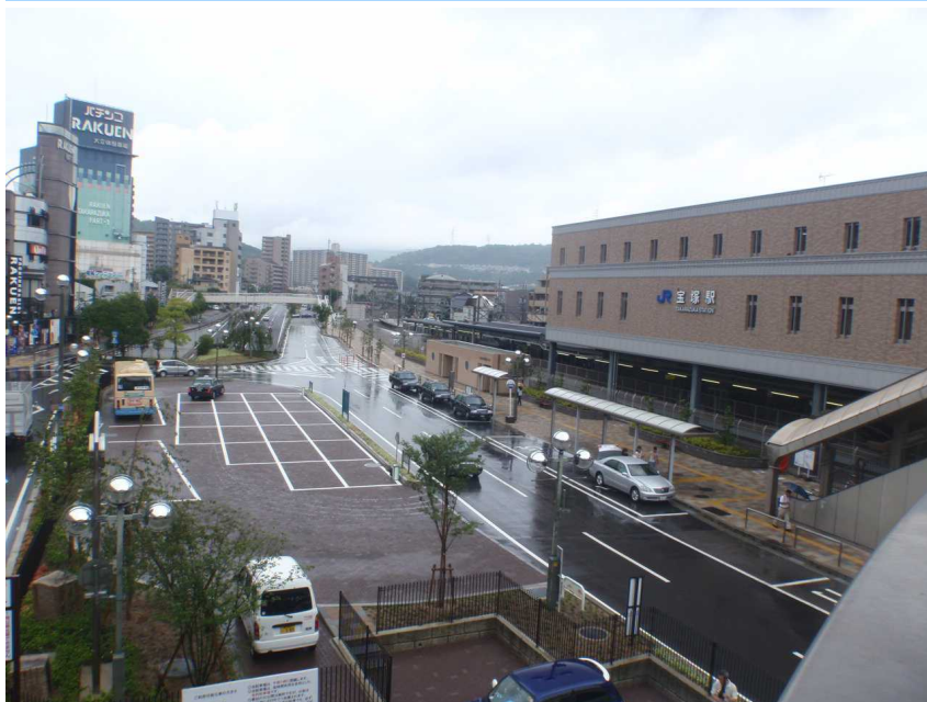
平成24年4月撮影 橋上化後の JR宝塚駅駅舎
