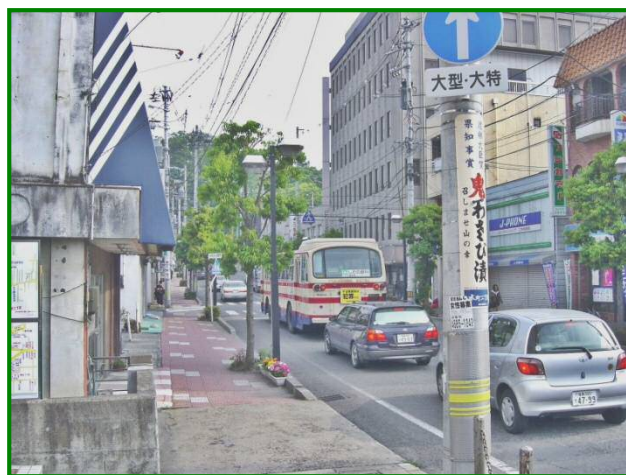
電線や段差の目立つ道路
