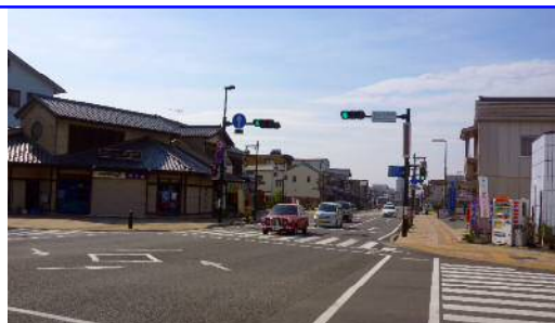
右折レーンの設置により、交通もスムーズに
