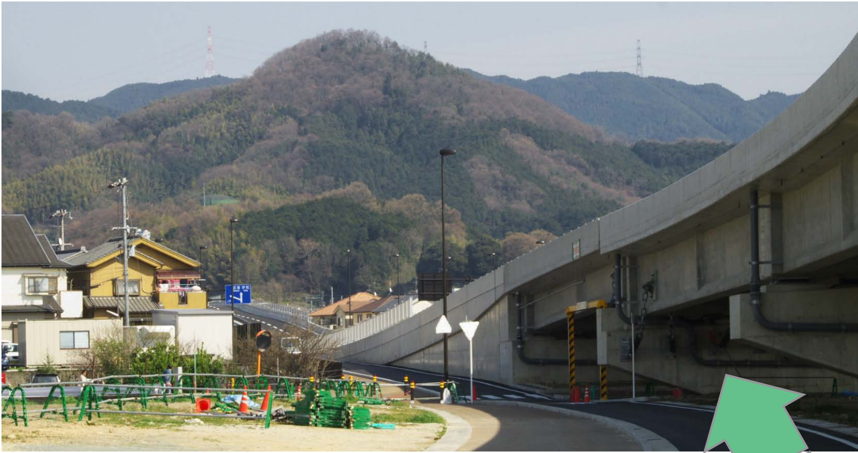
景観に配慮し 高架橋の一部 を下げた区間
