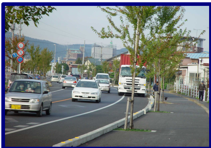
樋ノ口河合線の供用状況
