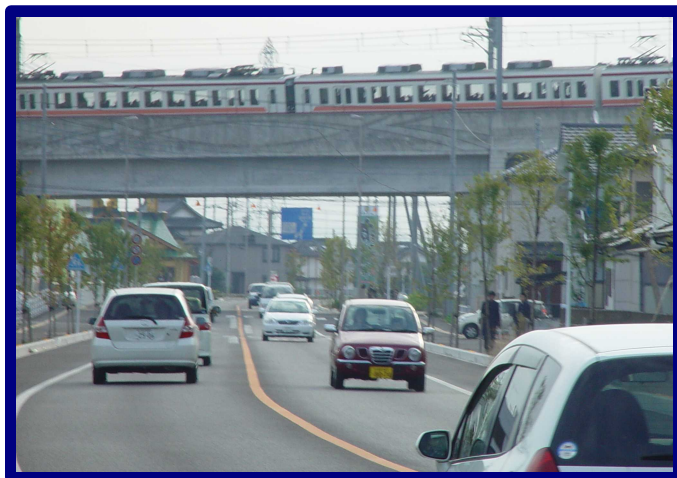
樋ノ口河合線の供用状況
