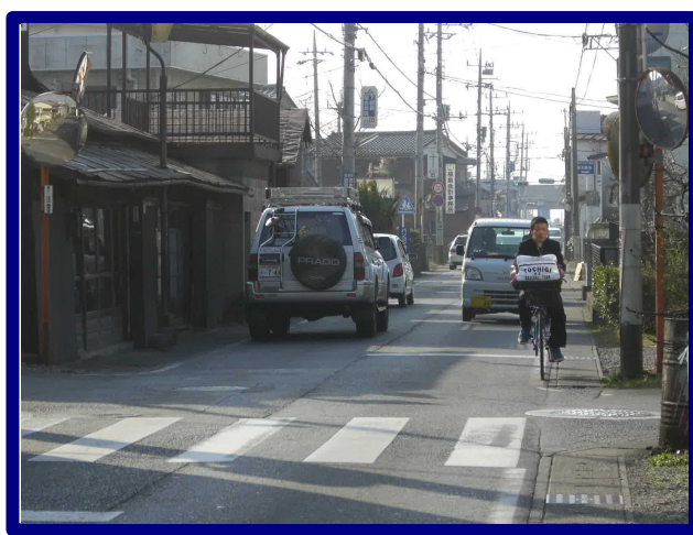
(主) 栃木小山線の供用状況
