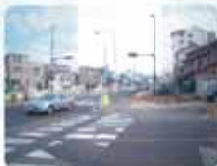
工事の様子 19年12月撮影
