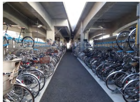
武蔵境駅～東小金井駅間の駐輪場整備
