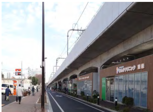
武蔵境駅～東小金井駅間の側道整備
