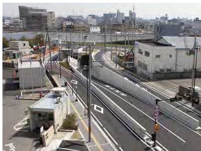
JR西側擁壁区間
