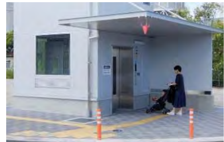
地下歩道へのエレベーター（バリアフリー動線）
