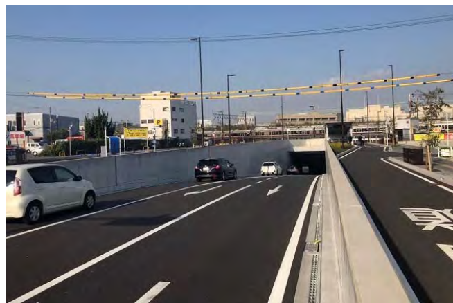
JR東側擁壁区間
