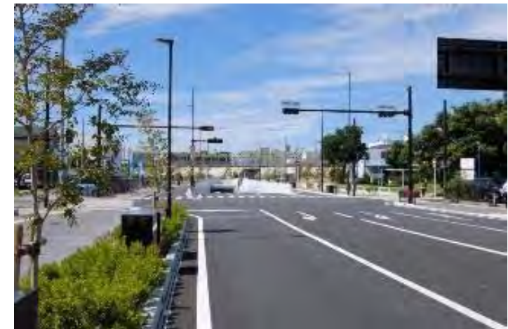
JR東側区間（電線共同溝による無電線化）
