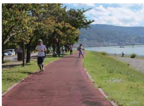
ジョギングロードの舗装は、ゴムチップウレタンを使用し、適度な断力性と快適性、安全性を持たせている。
