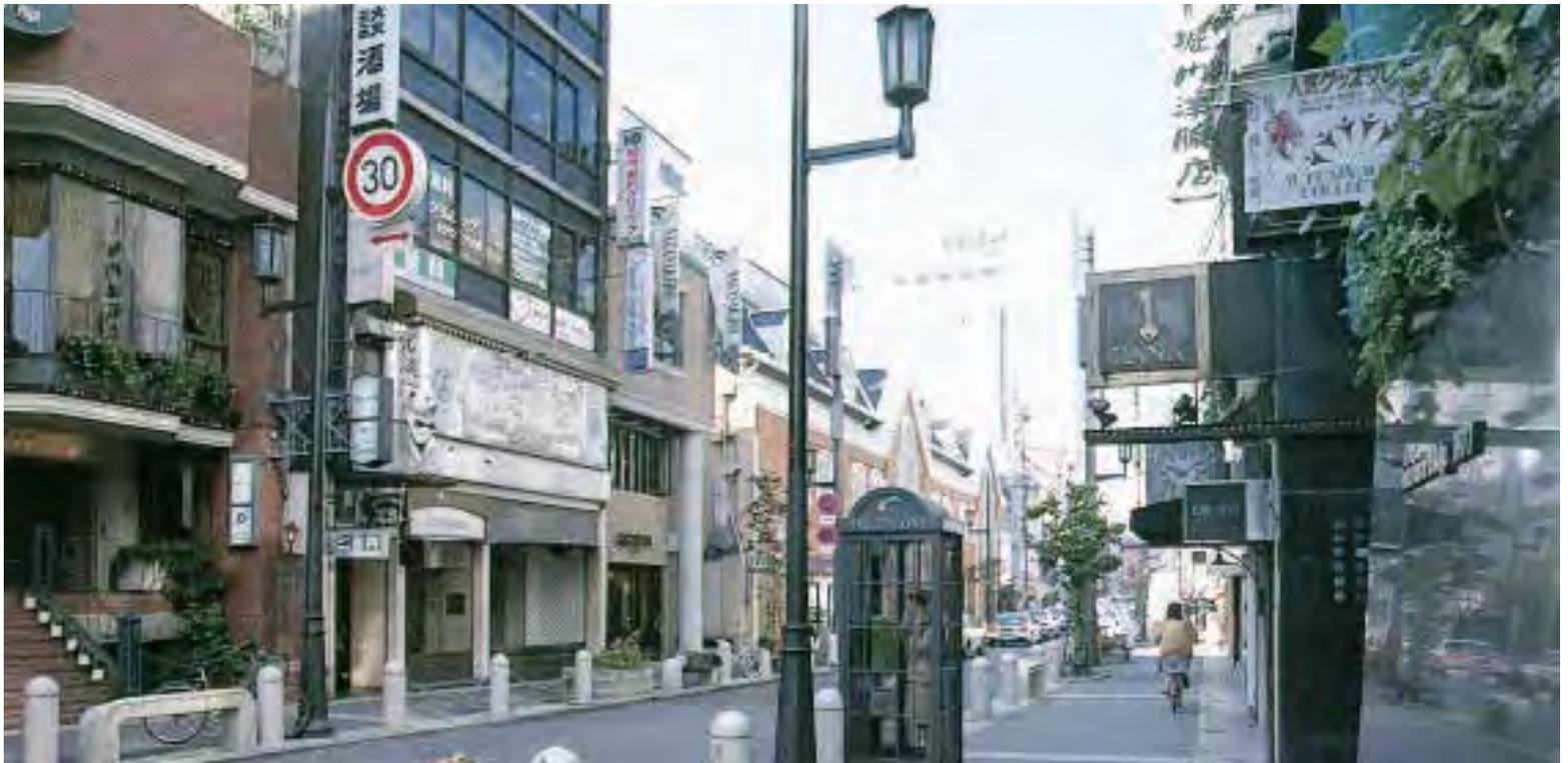
整備後のヨーロッパ村。歩道を拡げて電線類を地中化し、石畳をイメージした車道・歩道部のブロック舗装をはじめ重厚な照明灯や車止めを整備し、美しい街に生まれかわった。
