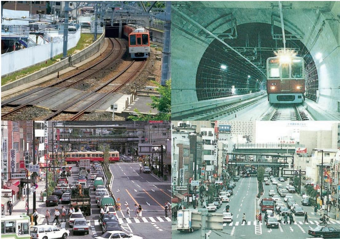
左上：地下移行部、右上：鉄道地下部、左下：整備前、右下：整備後（浄正橋筋踏切除却後）
