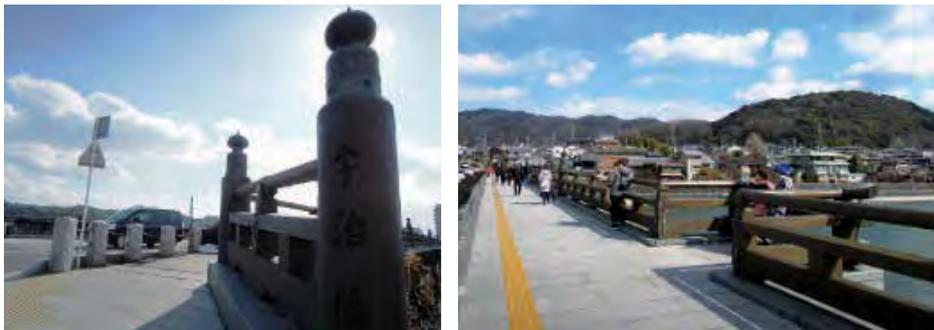
往事を偲ばせる外観・形状を継承した鳥居状の橋脚や桁かかし、歩道から張り出した「三の間」
