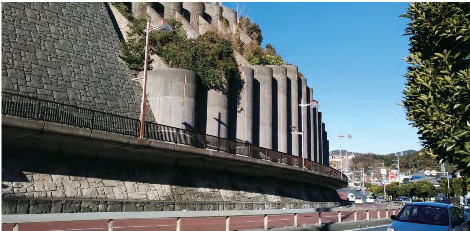
深礎擁壁の表面をピシャン仕上げにて処理することにより、巨大な構造物にありがちな威圧感を和らげている
