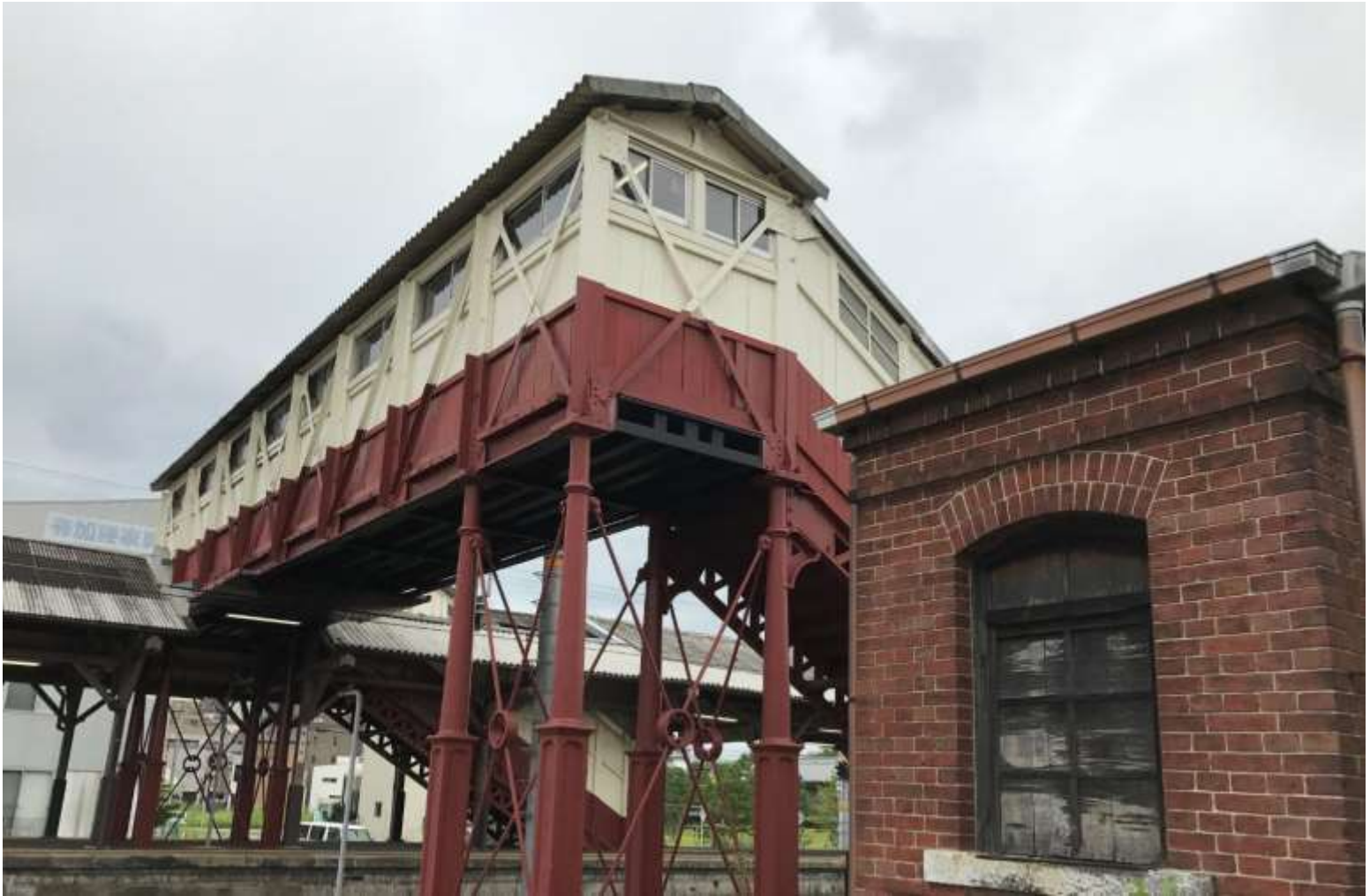
現存する日本最古の跨線(こせん)橋とレンガ造の油庫
