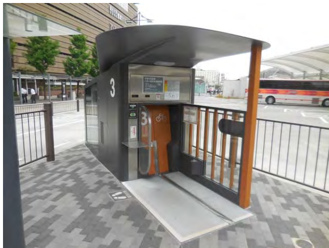
(1) 機械式地下駐輪場 (省スペースで収容力の高い駐輪場)
