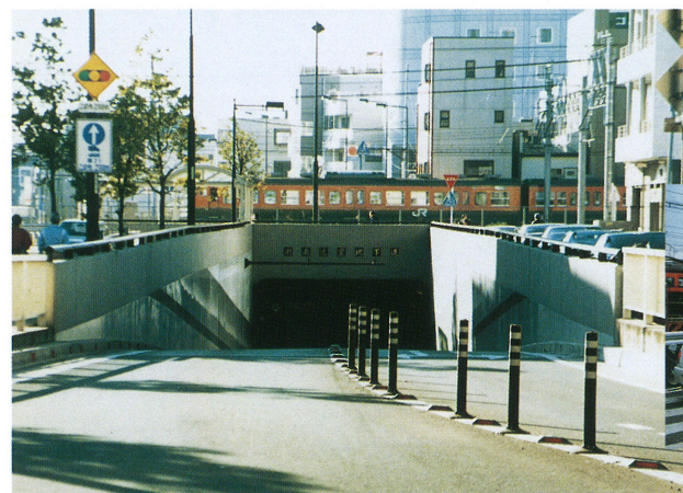
整備後(羽鳥立体)
