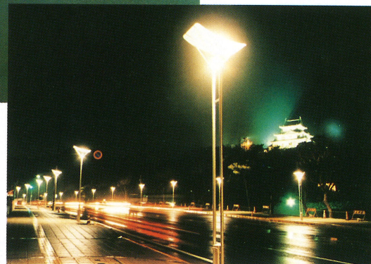
ライトアップされた和歌山城を背景にした道路
