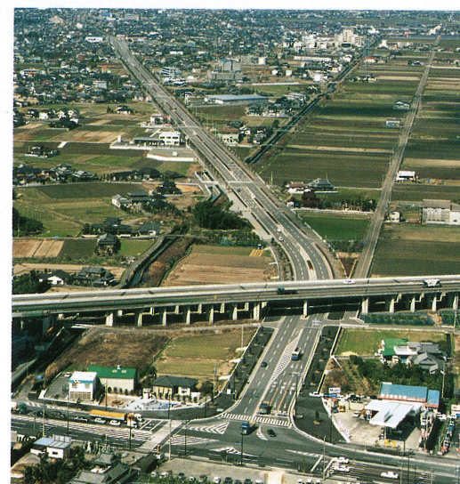
起点(国道3号)より終点側を望む
