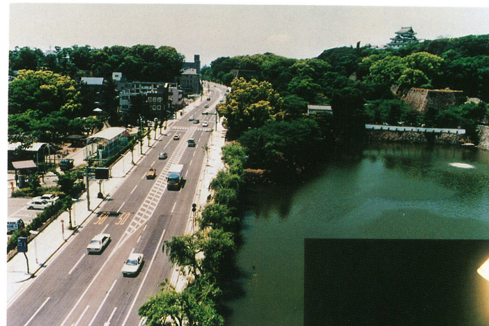
周辺の景観とマッチした道路整備
