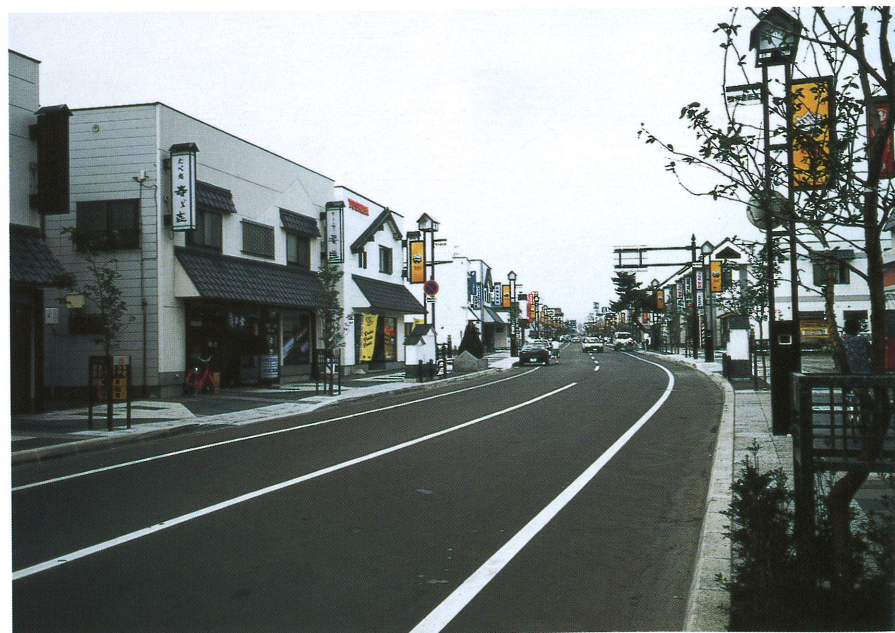
伊達街道の整備にあわせて景観統一が図られた沿道建築物
