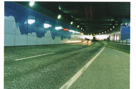
空港トンネル内部（東側坑口方向を望む）
