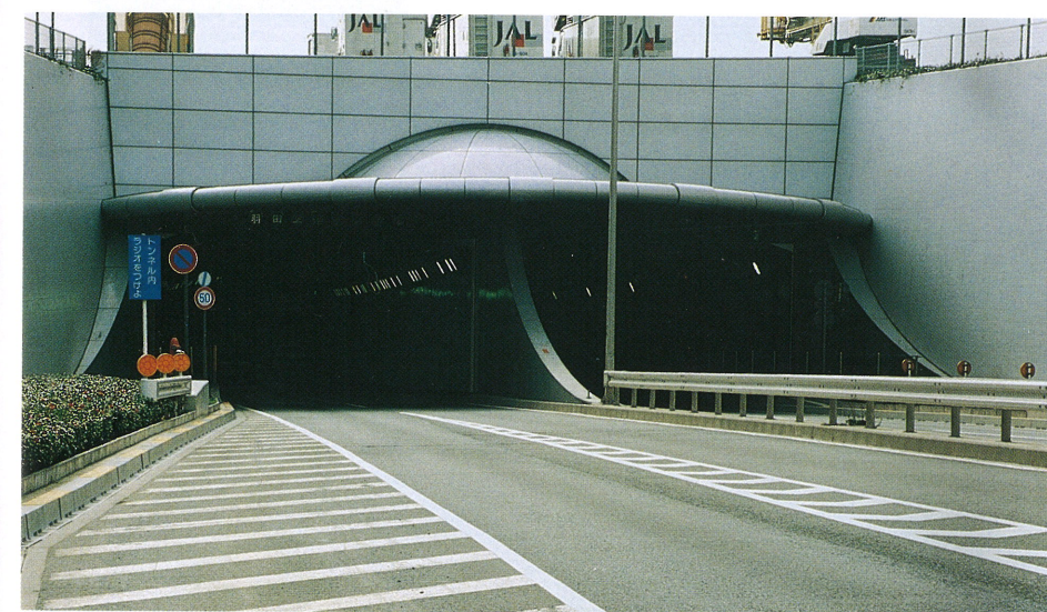
東側坑口（国道357号線から蒲田方向を望む）
