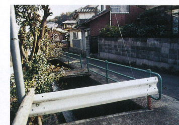
整備前のガードレール
