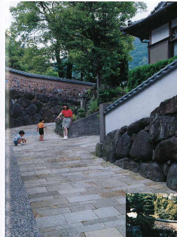
起点側全景（整備後）
