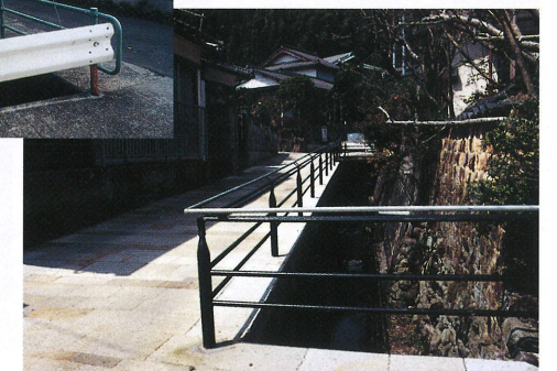
景観に調和した河川の手摺り（整備後）
