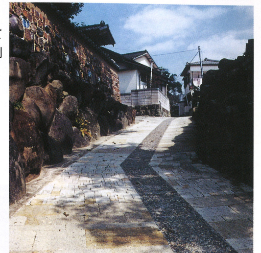
自然石によるきめ細かいデザインを施したみちと排水溝の整備
