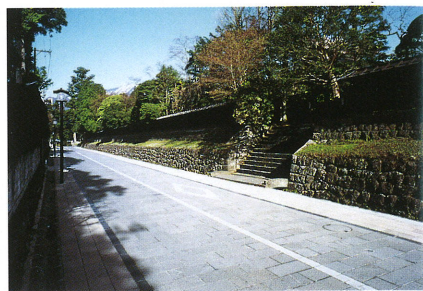
冬のリップ防止も兼ねるミカゲ石の舗装
