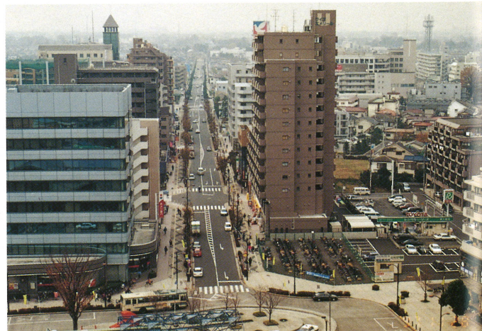
駅西口広場からのびるシンボルロード（まろにえ富士見通り）
