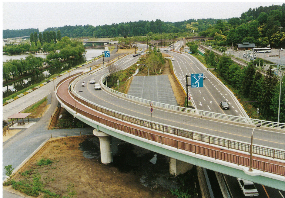
常磐陸橋側より交差点方向を望む
