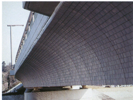
好文亭の桧葺き屋根の模様をデザインしたアルミ製桁化粧柱
