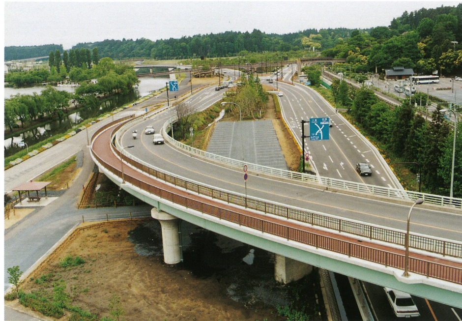
常磐陸橋側より交差点方向を望む
