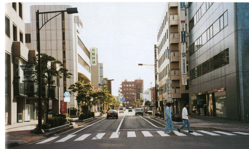
起点側から終点側を望む
