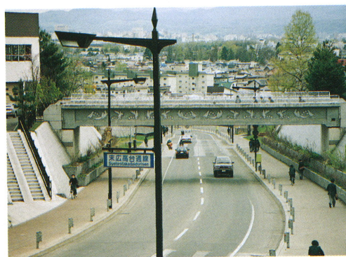
沿線にある旭川実業高校への連絡橋（壁面のデザインは同校生徒のデザインによる）
