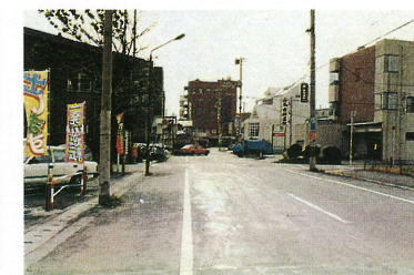
中間より起点側を望む（整備前）
