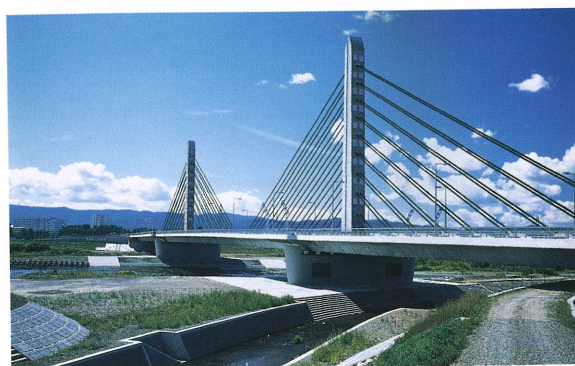
一面吊りの斜張橋
