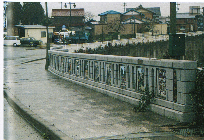
イロハカルタをはめ込んだ高欄
