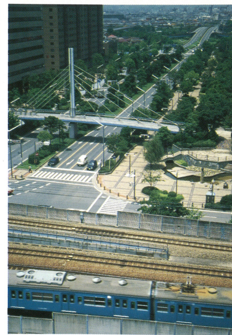
シンボルロードに架かる歩道橋
