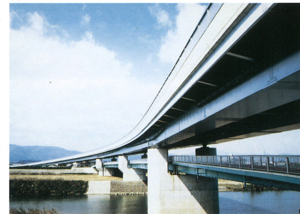
羽束師橋（上：車道橋、下：歩道橋）
