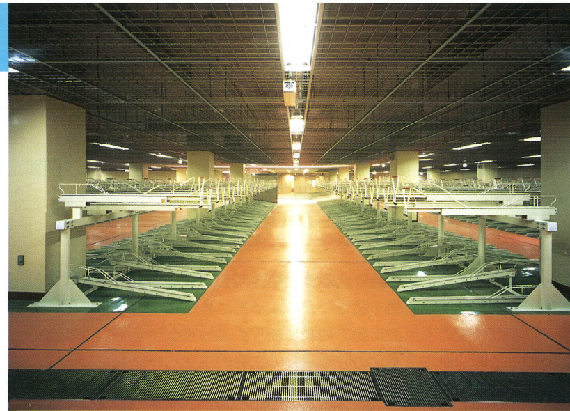
中央通路から南側ラックを望む
