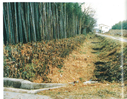
整備前に西側から東側を見た風景。
