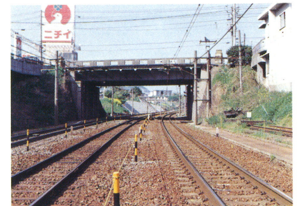
JR跨線橋部（整備前）
