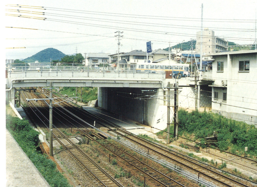
JR跨線橋部（旧橋：鋼板桁橋）、（JR山陽線及びJR山陰線）（整備後）
