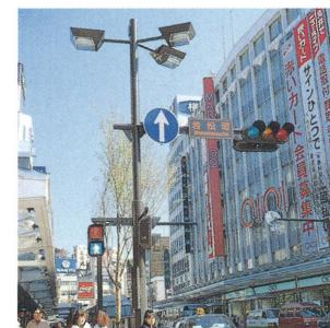
信号共架型照明／道路景観向上のため、地中化工事とあわせて、照明信号、規制標識等の柱類を一本化し、地上施設の整流統合を行なっている。柱の足もとにステンレスリングを採用したり、大きな張紙防止シートを巻きつける等の工夫も行ない、シンプルでおしゃれな照明となっている。
