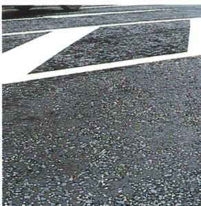
車道特殊舗装(改良明色舗装)／2種類のカラーチップ骨材を舗装表面に機械を使って敷きならべ、特定の色彩を出すという初の試みを行なっている。アスファルト合材も全く新しく開発し、使用した。いわば個性的なみちづくりに合わせたオーダーメードの舗装である。
