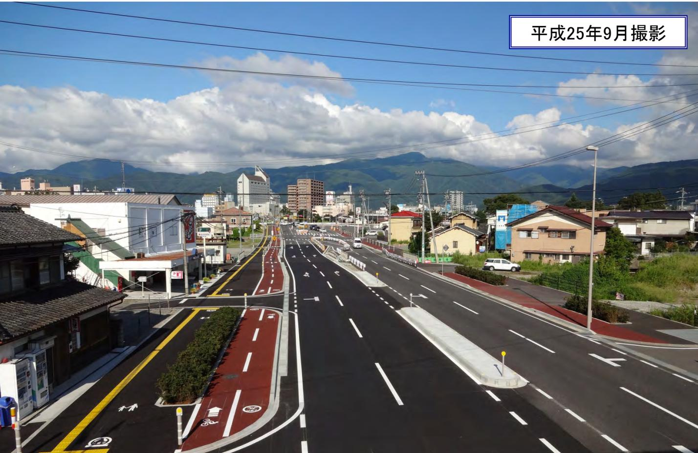
2車線から4車線への整備により、安全で円滑な交通が確保され、市街地への流入が飛躍的に向上した。歩道部には、あらたに歩道、自転車道、横断歩道橋が整備され、隣接する小学校、中学校への通学に利用されている。
