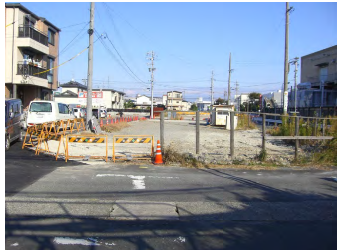
④(主)名古屋祖父江線との交差部方向を望む
