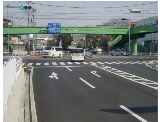
⑧（主）名古屋祖父江線との交差部を望む
