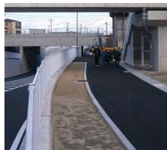
完成後のJR交差部 (事業箇所)
