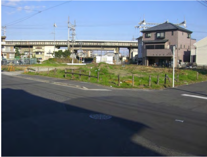
①西から東へ望む（新幹線高架部）
