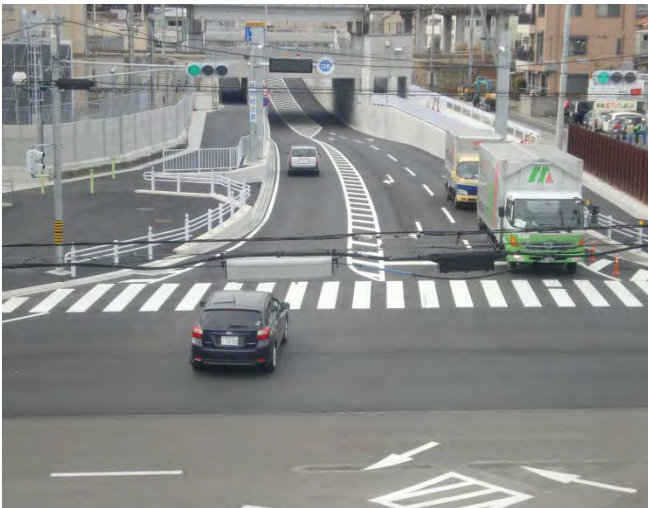
⑦東海道本線交差部を東から西へ望む（遠距離）
