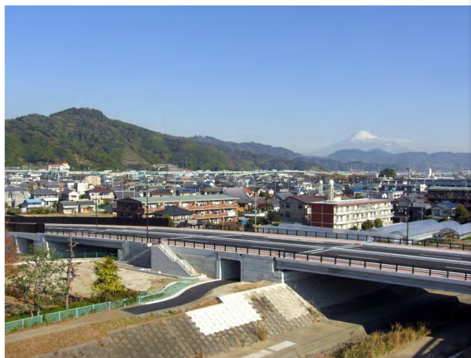
橋梁部西側から東側を望む
