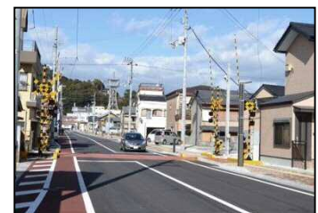
軌道敷内の安全性確保
