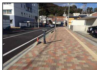
安全な歩道空間
