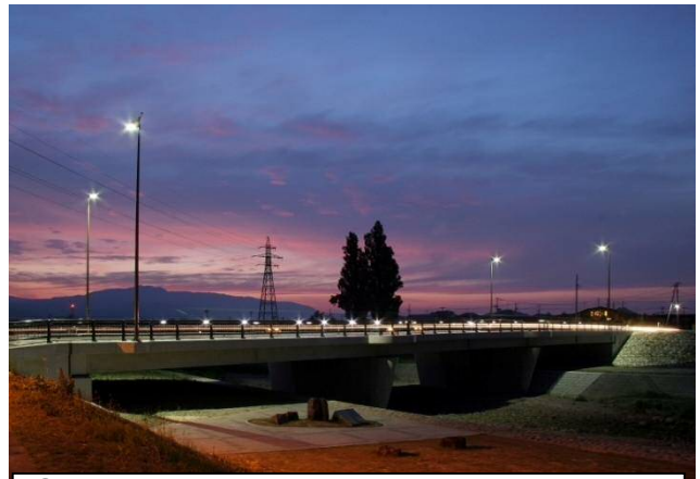
④LEDを採用した橋梁照明(平成23年6月撮影)
