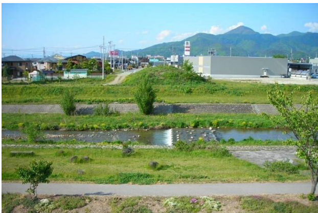
②逆方向より撮影(神町側より東根側を望む) (平成21年5月撮影)
