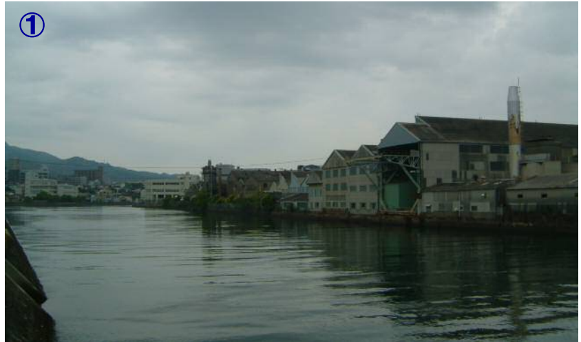
幸町工区 着手前の工場等
