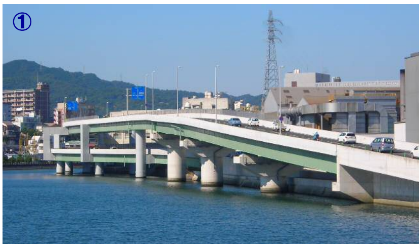
幸町工区 浦上川高架橋完成
