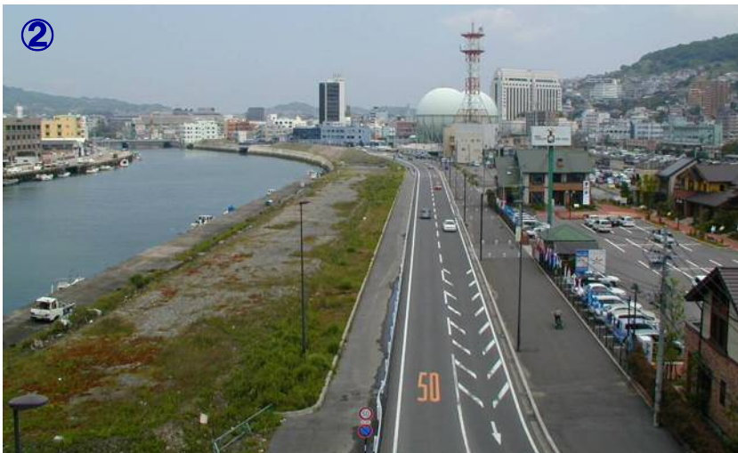
尾上町工区 JR長崎駅西側 (暫定2車線)
