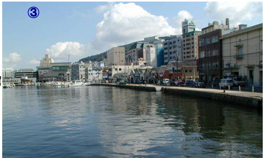
元船町工区 埋立前の港湾 施設
