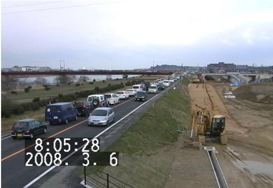
南側から八千代橋東詰を望む
