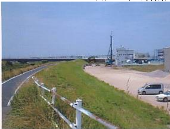
南側から千代大橋東詰を望む
