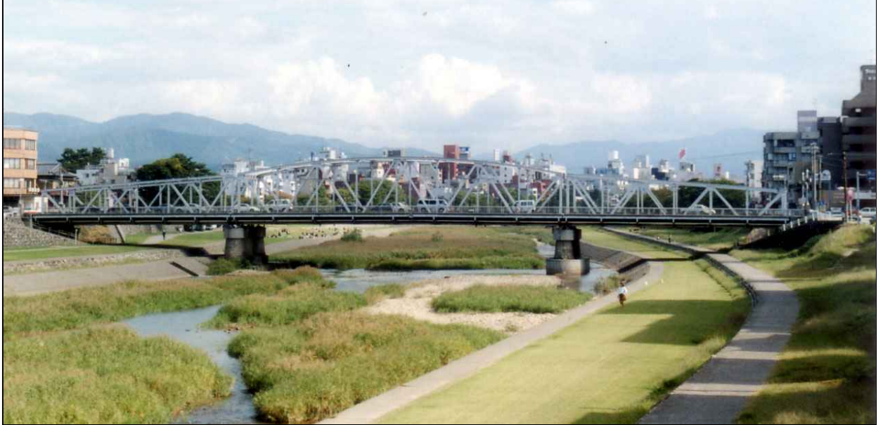
平成8年10月撮影（犀川下流より旧御影大橋を望む）
